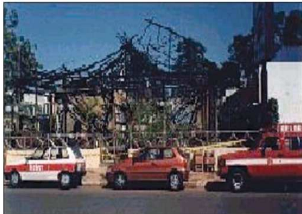
Figura 2: Incêndio em edificação com cobertura de fibras vegetais (ocupação de bar e restaurante)
