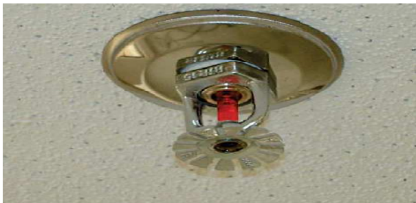
Figura 22: Chuveiro automático
